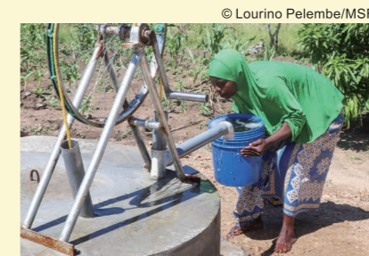
水をくむラビアさん。取っ手を動かすと車輪が回 り、地下水をくみ上げる。 © Lourino Pelembé/MSF
