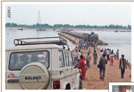
この橋は、雨季の増水で橋の途中が壊れて、以降船で渡ることになってしまった。
