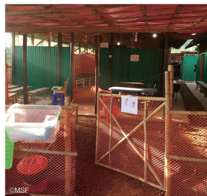
感染症対策のための院内の仕切り。
