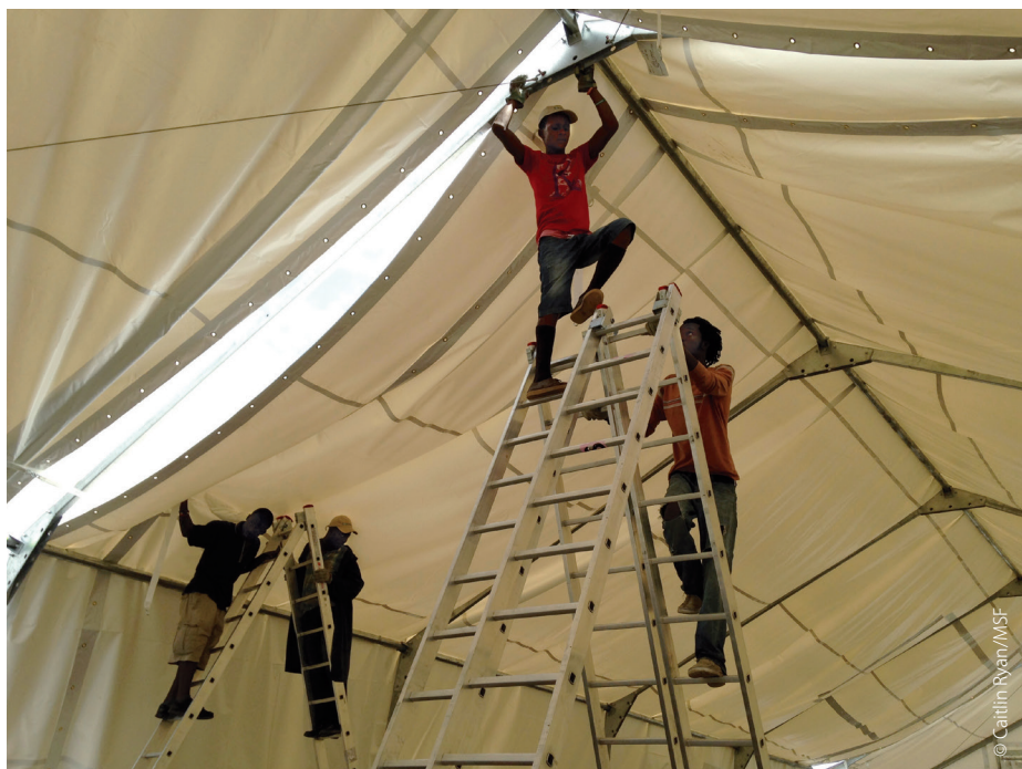
首都モンロビア郊外のMSFエボラ治療センター「ELWA-3」の一部となる施設を建てるチーム。
